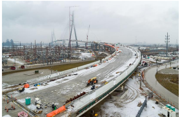
Avance de la construcción del Puente Internacional Gordie Howe.
