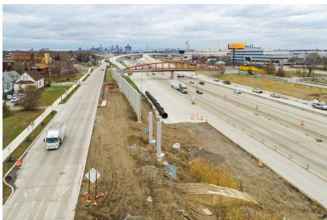
Avance de construcción de la obra en la I-75.
